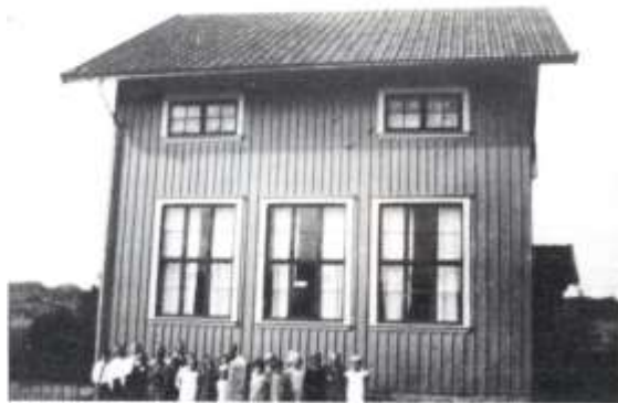
Skolklass framför Låghems skola 1931-32. Det byggdes 3 st skolhus i Svarteborg 1923 efter samma ritning, som gjorts av kommunalordföranden J.H. Lindqvist Aspång, ett av dem på Julseröd, ett på Låg hem och ett på Duesvärå
